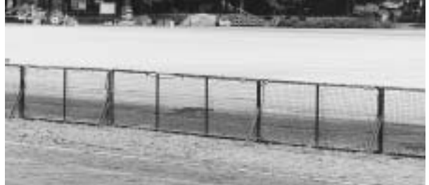
改修された中央公園グラウンド
