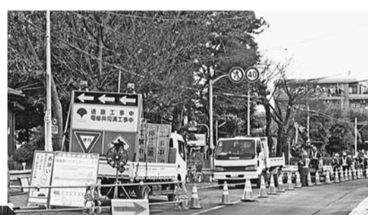
大沼町地域の東京街道拡幅工事の様子
