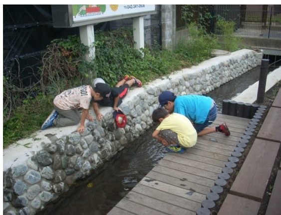
用水路の親水整備
