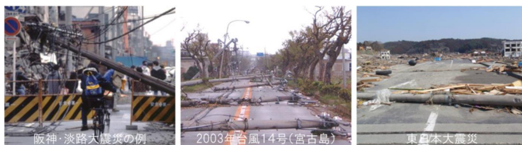
図8 災害時の電柱倒壊事例
