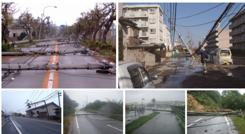
図1 電柱倒壊の被害事例
