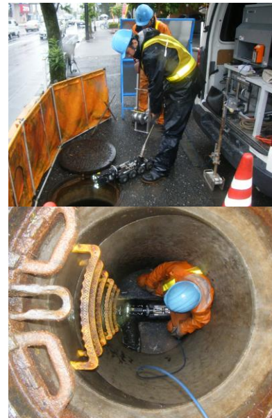
写真 3-7 管きょ内調査の状況
