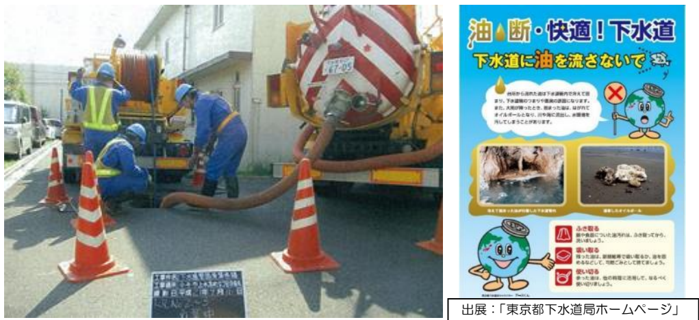
写真 3-5 管きよ清掃状況及びリーフレット
