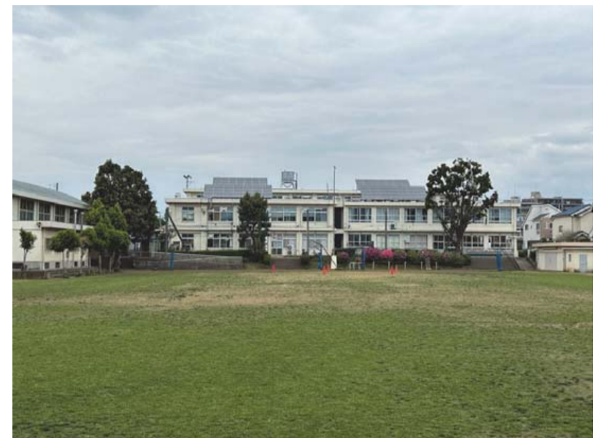
グラウンドと校舎外観
