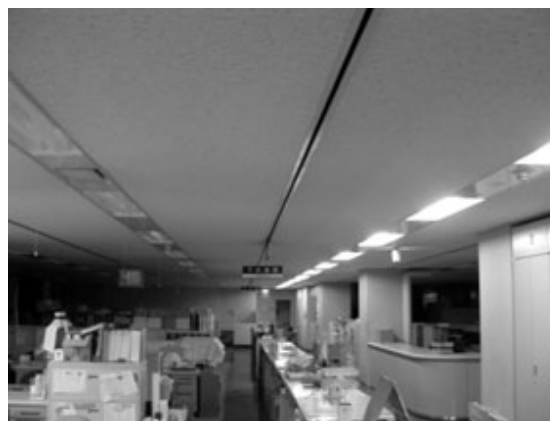
照明器具改修の例（市庁舎）
