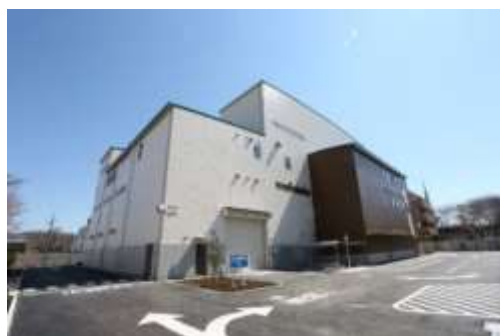
資源物中間処理施設の外観
