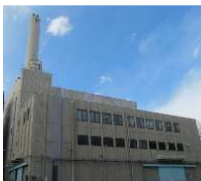
小平・村山・大和衛生組合の外観
