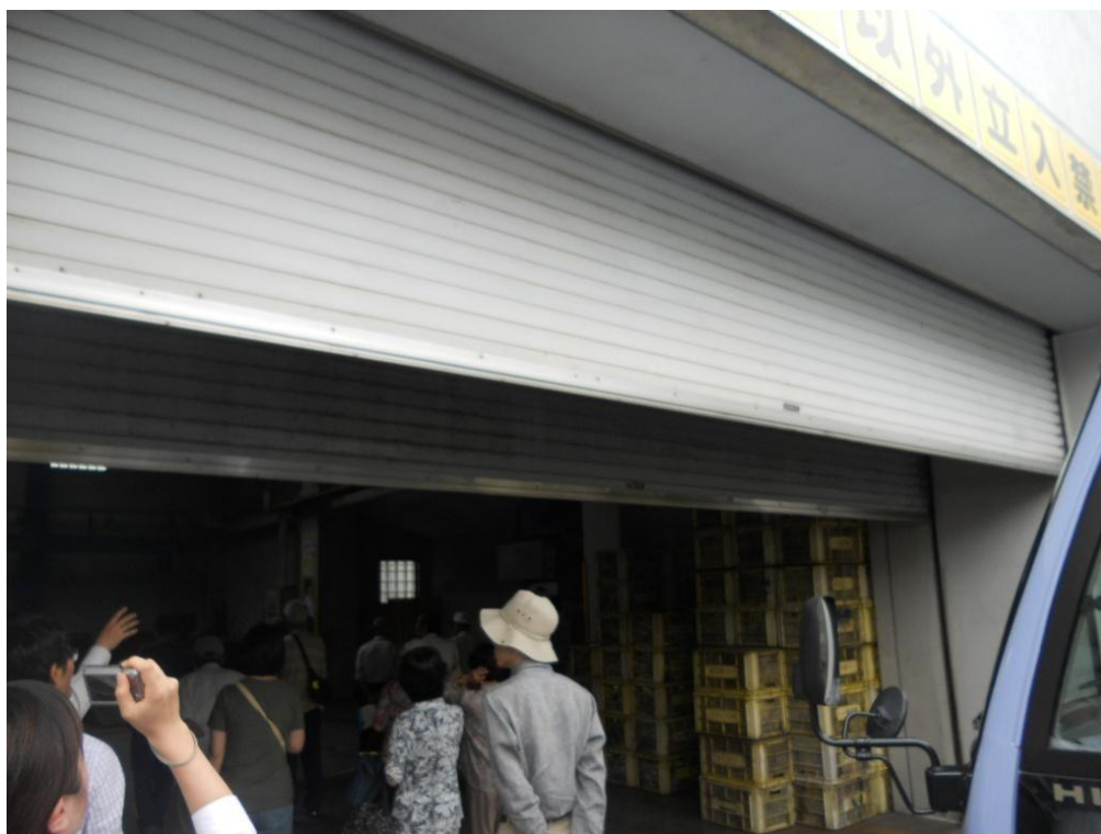
作業フロアへの車両進入口（二重シャッターで防音）
