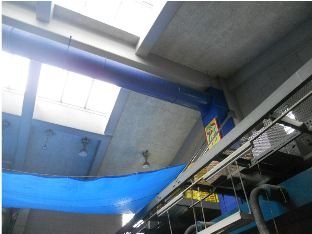
光を取り込む大きな窓（天井）
