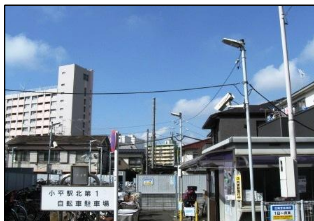
LED照明に交換した自転車駐車場の街路灯
