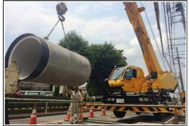
雨水管きよ築造工事の様子
