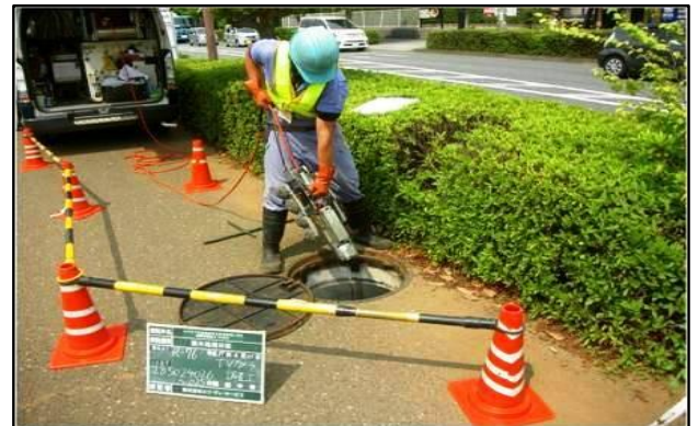
テレビカメラによる管路調査のようす
