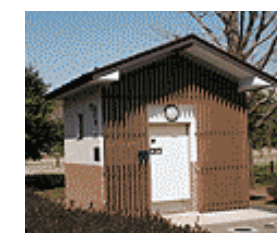
トイレの設置
