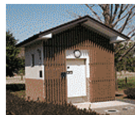
トイレの設置
