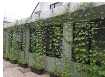
壁面緑化 (狛江市)
