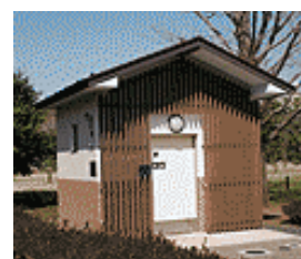
トイレの設置
