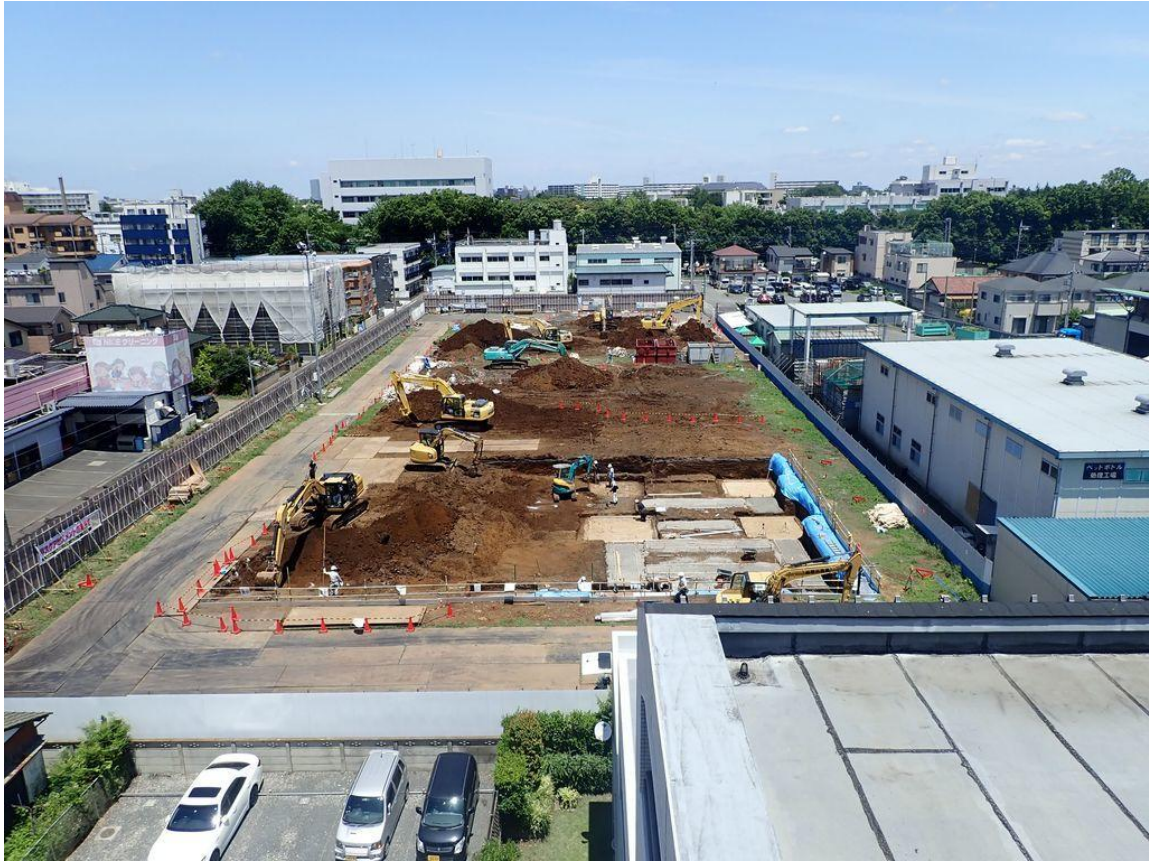
・ 土工事 (平成30年6月8日時点)
