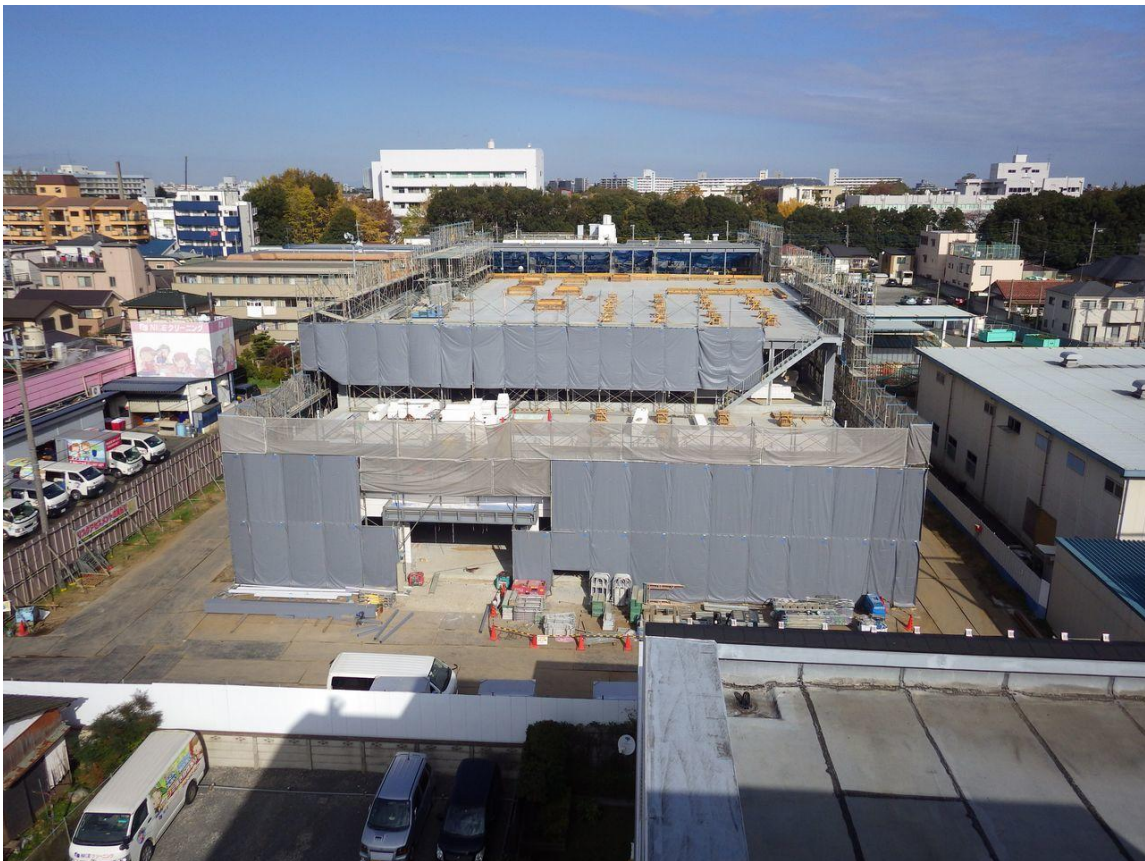
・鉄骨・外壁工事（平成30年11月24日時点）
