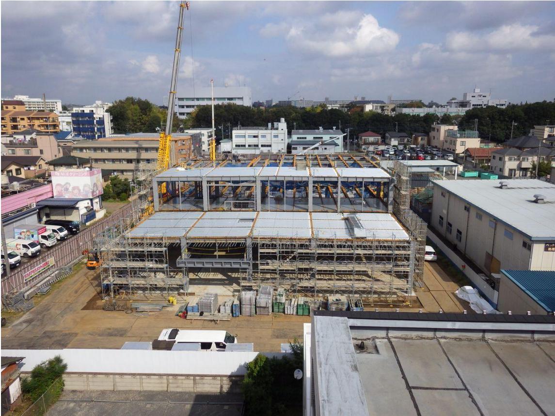
・鉄骨工事（平成30年10月10日時点）
