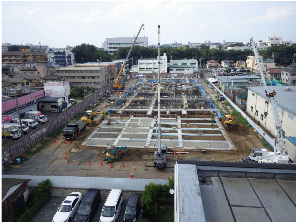
・ 基礎、土工事 (平成30年8月3日時点)
