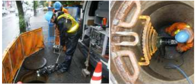
管きょ内調査の状況
