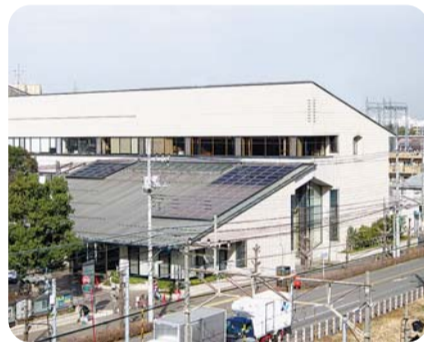
公共施設への太陽光発電設備の設置
