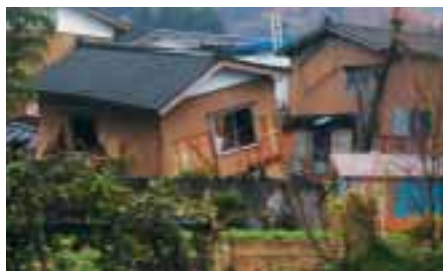
1階がつぶれ傾いた住宅（長岡市）
